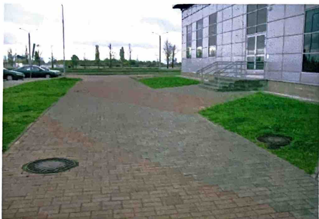
Колодцы хозяйственно бытовой канализационной сети
