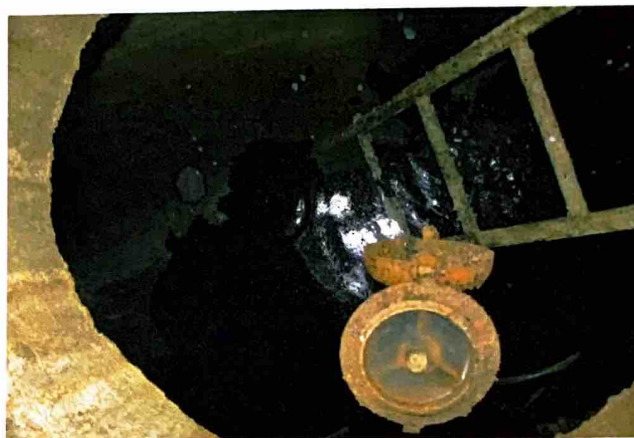
Врезка водопроводной сети
