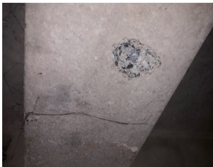
Фото 10. Вскрытие арматуры ригеля перекрытия.
