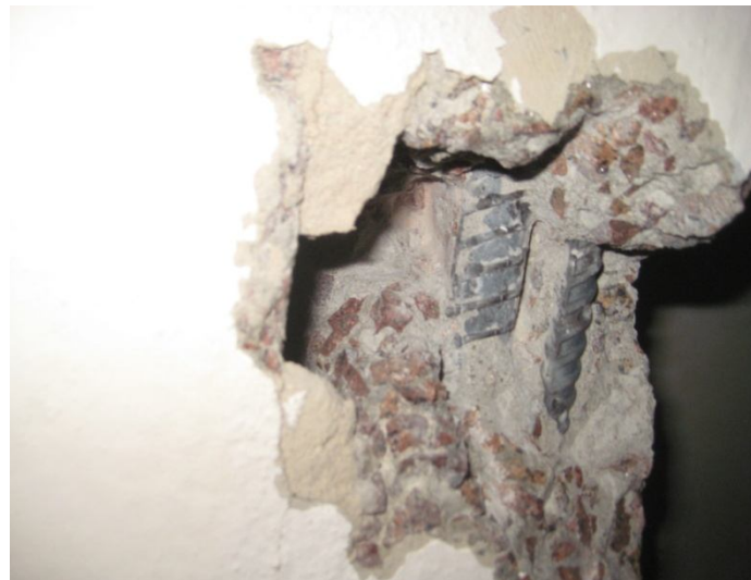
Фото 66,67. Вскрытие арматуры ригеля и плиты перекрытия.
