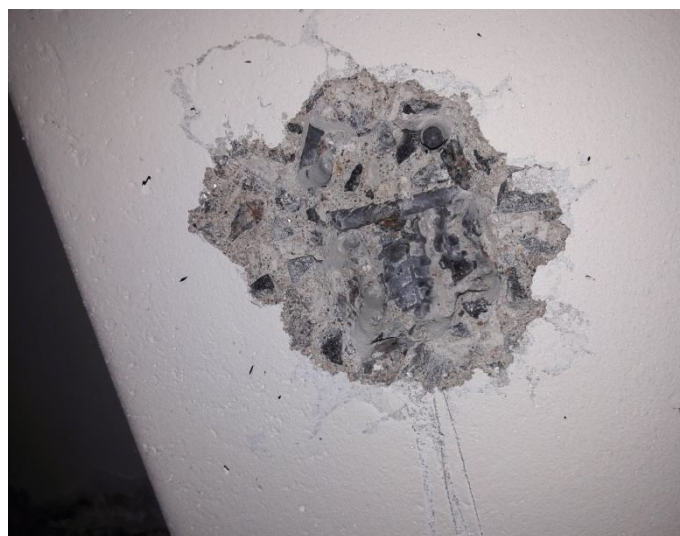
Фото 33. Вскрытие арматуры ригеля перекрытия.
