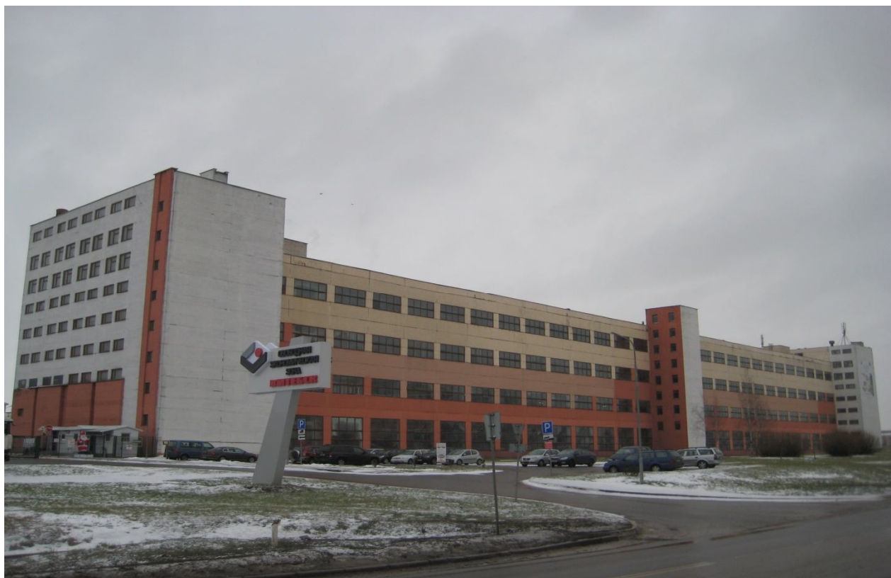
Фото 1. Фасад главного корпуса по оси Г
