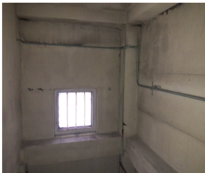
Фото 25. Ж/б каркас лестничной клетки.
