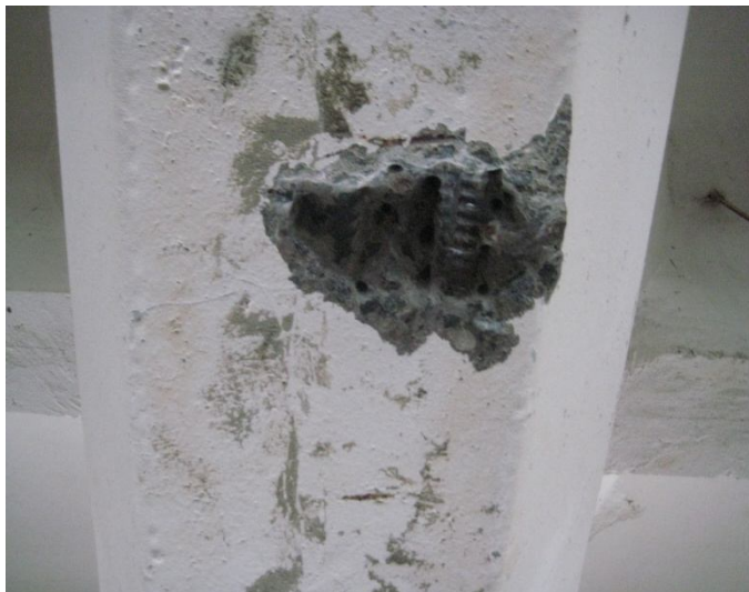
Фото 66,67. Вскрытие арматуры ригеля и плиты перекрытия.
